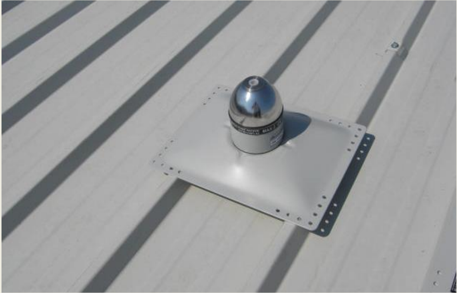
Particolare Piastre di ancoraggio.
